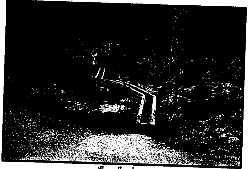
صورة تبين قنوات الري الاسمنتية المرممة حديثا
