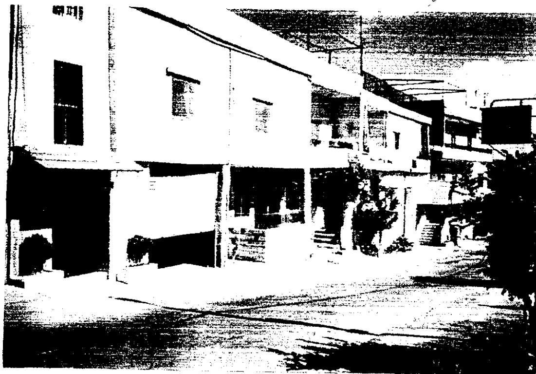
المنازل منتشرة على طول الطريق الرئيسي. (مدخل البلدة ) ويظهر مستوصف نيحا.
