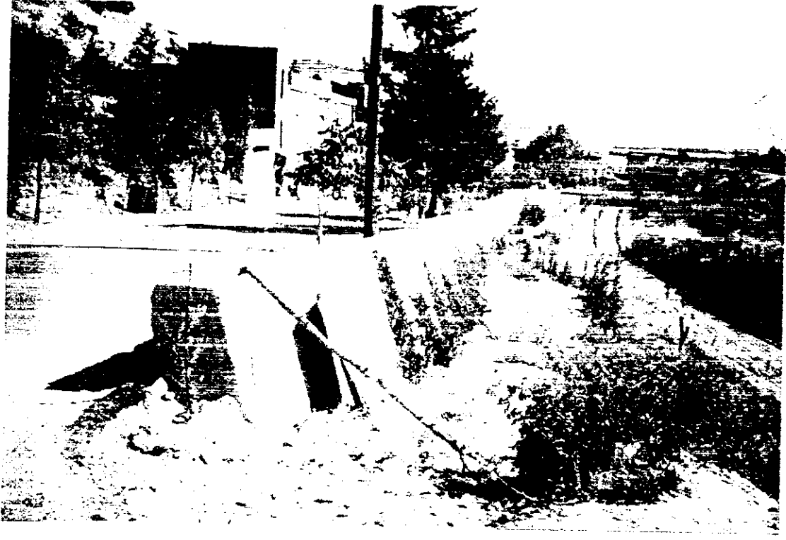
مدخل نيجا : حائط دعم يمين الطريق (نزولا ) لحماية الطريق.
